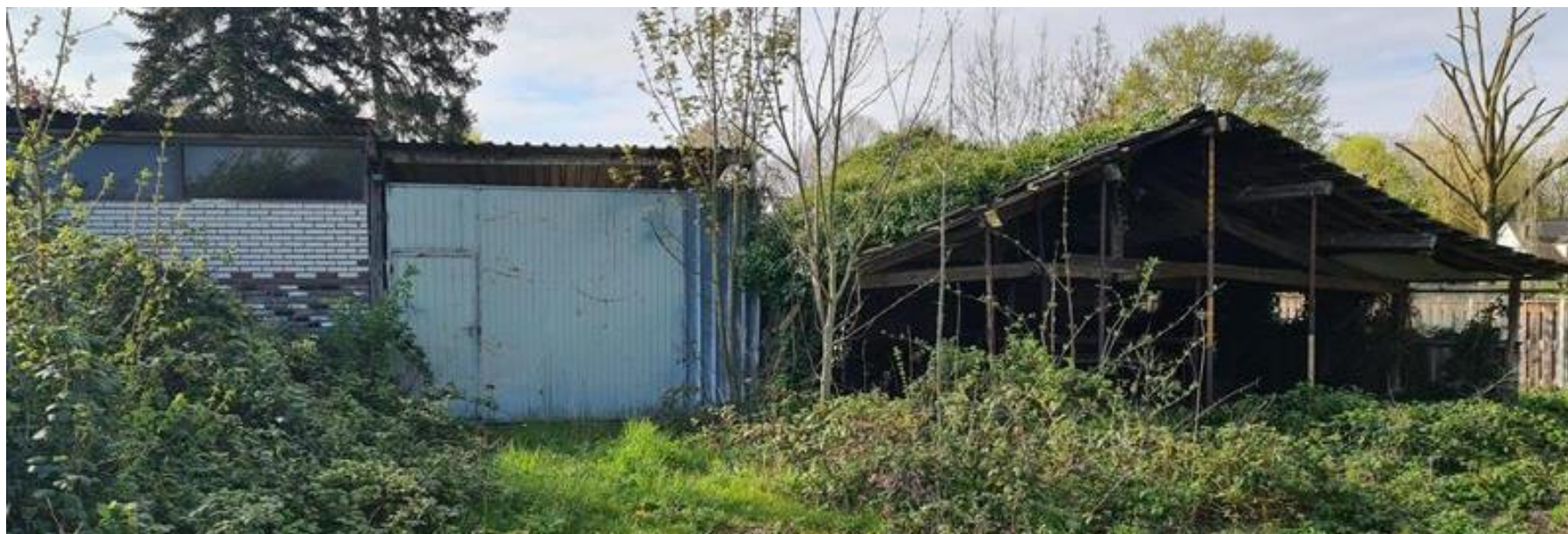
Figuur 3: Opstallen richting het zuiden van het plangebied
